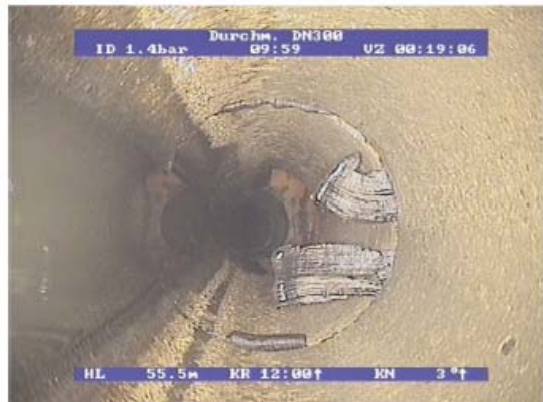
defekte Dichtung
